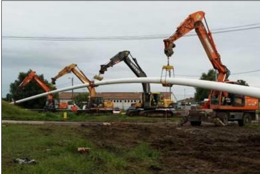
**Figure 33 : Exemple d'une mise sur caténaire**
